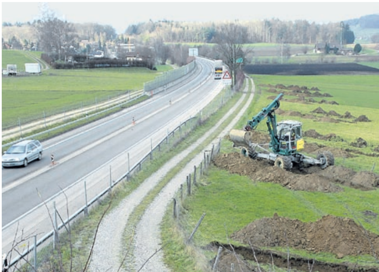
Neben der A4 wird mit einem Schreitbagger in Sondiergrabungen sorgfältig Schicht um Schicht abgetragen. Bild: Urs Baptista
